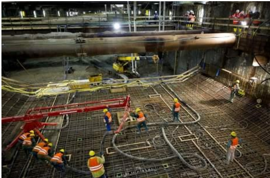
De betonnen vloer van station Rokin wordt gestort. © ANP
