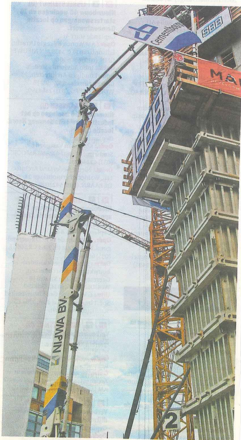
Het storten van de derde kolom in de witgelakte bekisting (foto rechts) en de tweede kolom nog ingepakt in wit folie (foto links).
